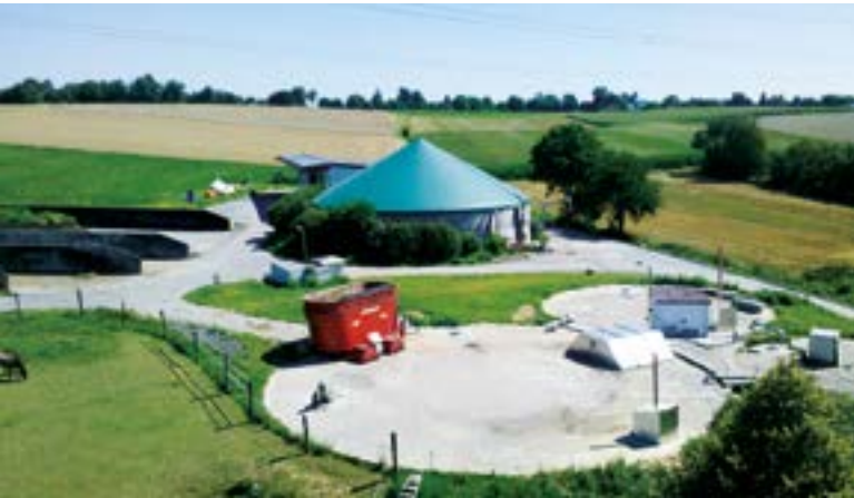
Blick vom Hochsilo auf die Biogasanlage
